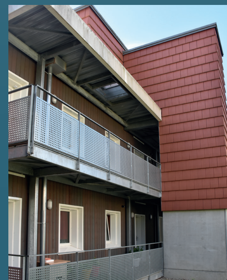
Résidence Jules Ferry / R+7 / Immeuble en paille Bailleur Toit Vosgien
