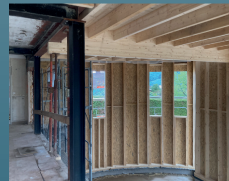
Installation de la structure bois
